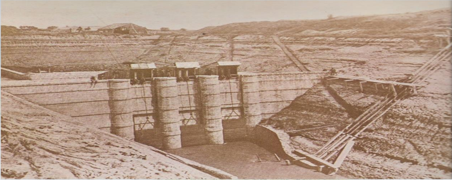
Presay compuerta del Túnel para el desagüe profundo
